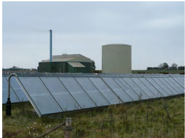
FIGURA 7. Captadors d'energia solar tèrmica i edifici de les calderes de biomassa a l'Illa de Samso, Dinamarca.
